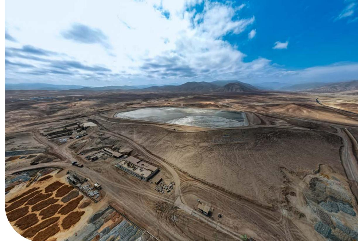
D'autre part, nous avons placé des barrières physiques au-dessus du miroir d'eau pour empêcher l'accès des oiseaux et nous avons réussi à imperméabiliser, avec du polyéthylène haute densité, les canaux d'urgence de conduite des résidus miniers et la recirculation de la solution stérile, dans le cadre de la mise en oeuvre du Code international du cyanure.
